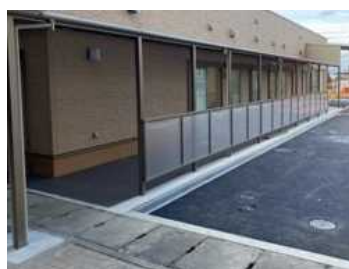
外部廊下 患者と医療従事者の動線を 完全に分離
